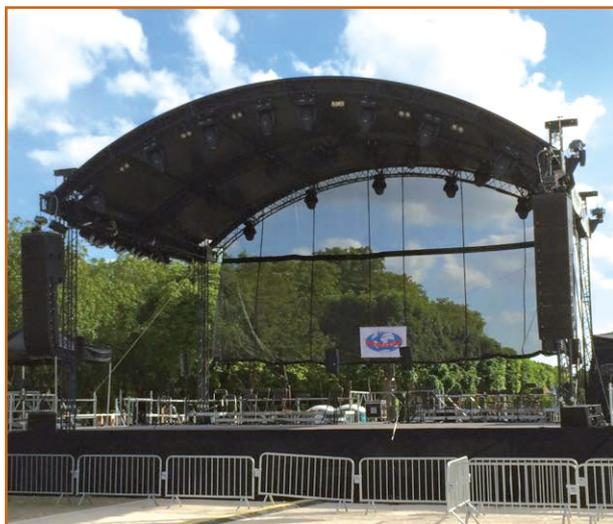
Réalisée sur la base de tours TL 290 et d'éléments standards et sur mesure SC 390 / EX 390, la scène couverte (toît uniquement) à toît arrondi offre une surface de 12 x 8 m. Livrée complète (hors motorisation et bâche) avec note de calcul, elle comprend :
